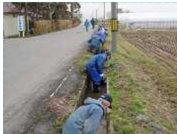
開水路の泥あげ(堰堀)
